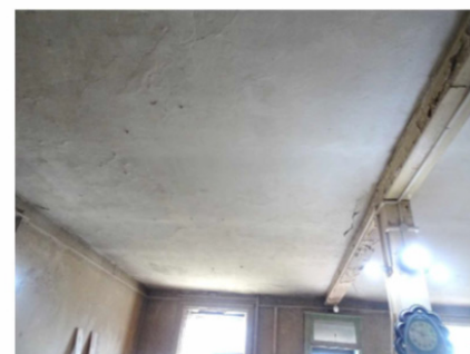
Фото 7, 8. Следы намокания на потолке, трещины, разрушение штукатурного и окрасочного слоев.
