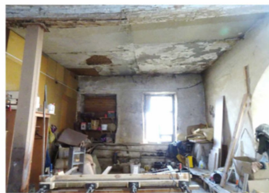
Фото 5, 6. Следы намокания в помещении здания. Осыпание штукатурного слоя.
