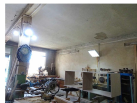
Фото 9, 10. Следы намокания на потолке, трещины, разрушение штукатурного и окрасочного слоев.
