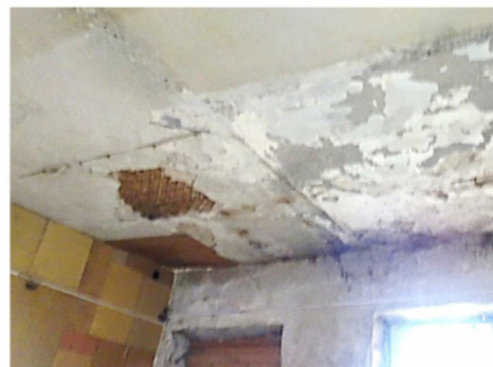
Фото 5, 6. Следы намокания в помещении здания. Осыпание штукатурного слоя.
